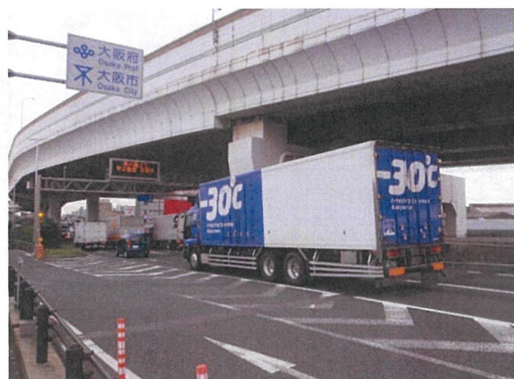
辰巳橋（新規設置後 8 年）
