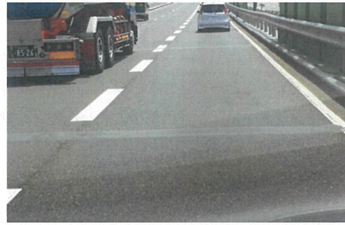
地 域：大阪府 阪神高速道路 件 名：阪神高速東大阪線 施工時期：平成 21 年 10 月 内 容：SJ-M 型（横目地） 交 通 量：132,837 台/日 センサス調べ
