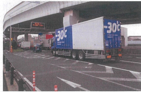
地 域：大阪府 国道 43 号線 件 名：辰巳橋 施工時期：平成 18 年 2 月 内 容：SJ-M 型（横目地） 交 通 量：85,293 台/日 センサス調べ
