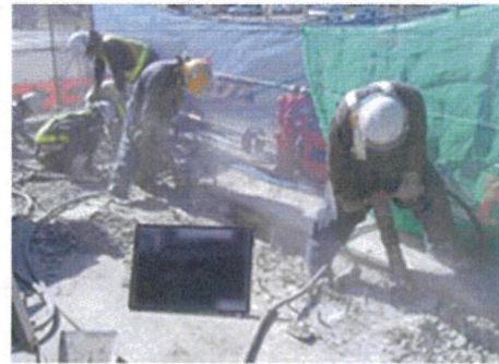
補修方法=全体交換
