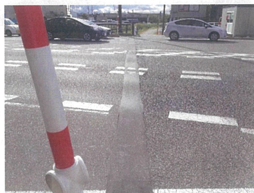
写真④ (施工後約8年)
