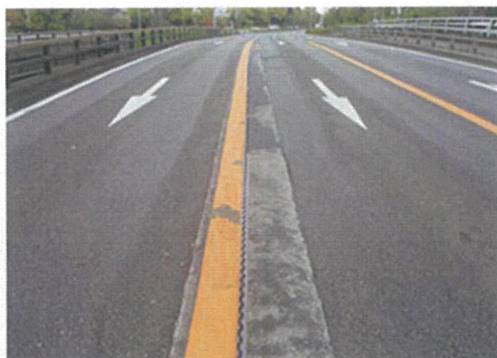
簡易鋼製ジョイントの縦目地例
