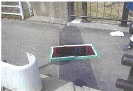
不透水試験（歩道）
