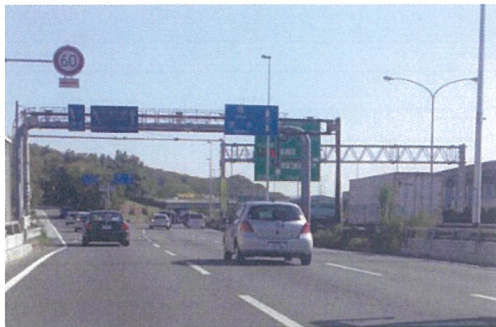
地 域：大阪府 大阪中央環状線 件 名：山田上高架橋 施工時期：平成 19 年 内 容：SJ-MD 型（横目地） 交 通 量：96,553 台/日 センサス調べ
