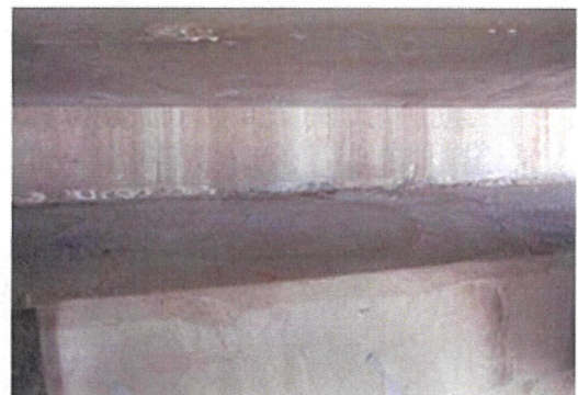
桁下への漏水なし
