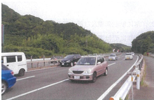
地 域：福岡県 国道 3 号線 件 名：佐山池栈道橋 施工時期：平成 15 年 内 容：SJ-M 型（横目地） 交 通 量：75,919 台/日 センサス調べ
