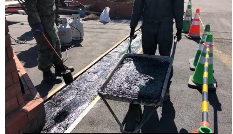
敷設：流し込み施工で隅々まで充填
