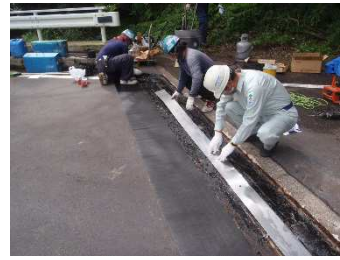
敷板設置工状況
