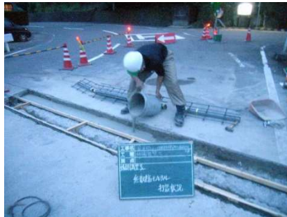
モルタル打設状況
