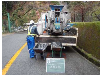
専用溶融機による特殊合材溶融状況
