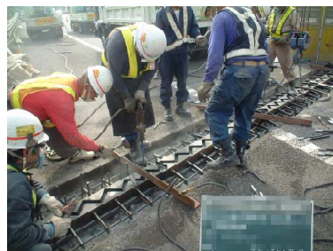
差し筋アンカー穿孔打込状況
