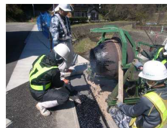
特殊合材舗設状況
