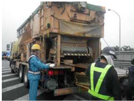
超速硬コンクリート打設
