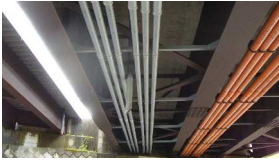
桁下 (鋼橋) 添架管に注意
