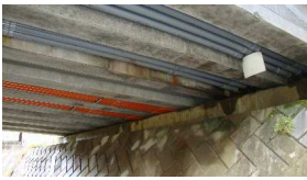
桁下 (コンクリート橋) 添架管に注意
