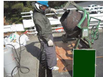
特殊合材溶融混合状況
