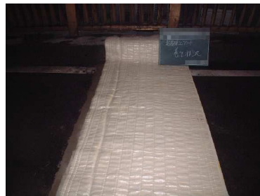
コンクリート養生
