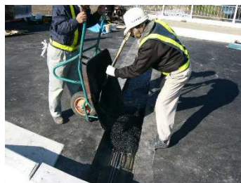
特殊合材舗設状況
