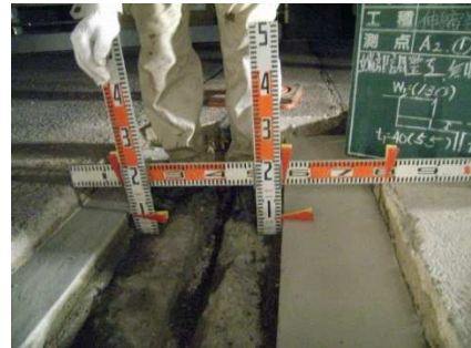
端部箱抜き成形工完了
