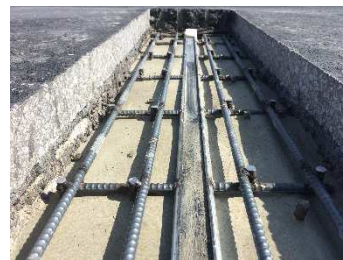
本体金具設置完了
