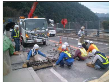
伸縮装置の据付
