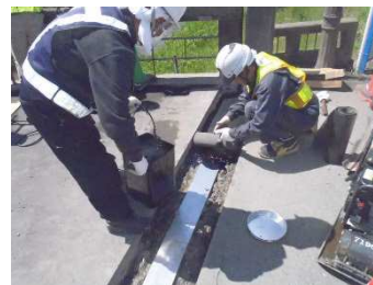
下地処理工状況
