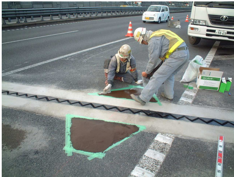
段差修正材使用例
