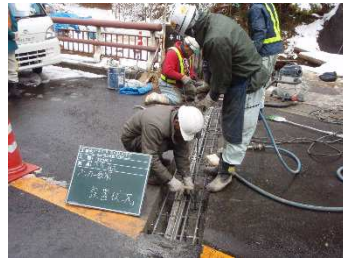
本体金具溶接工状況
