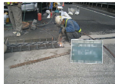
配筋溶接工
