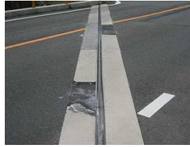
後打ち材の 合材による部分補修 痕
