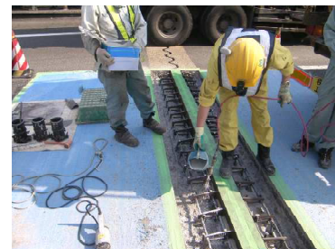
コンクリート打継接着剤使用状況
