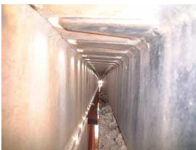
止水材なし (フィンガージョイント ウェブ内部)
