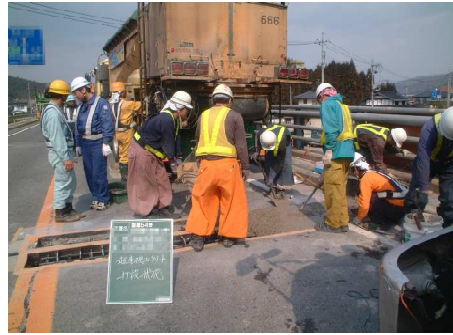
超速硬コンクリート打設
