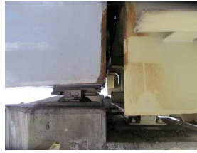
掛け違い部 支承周り拡大 桁端
